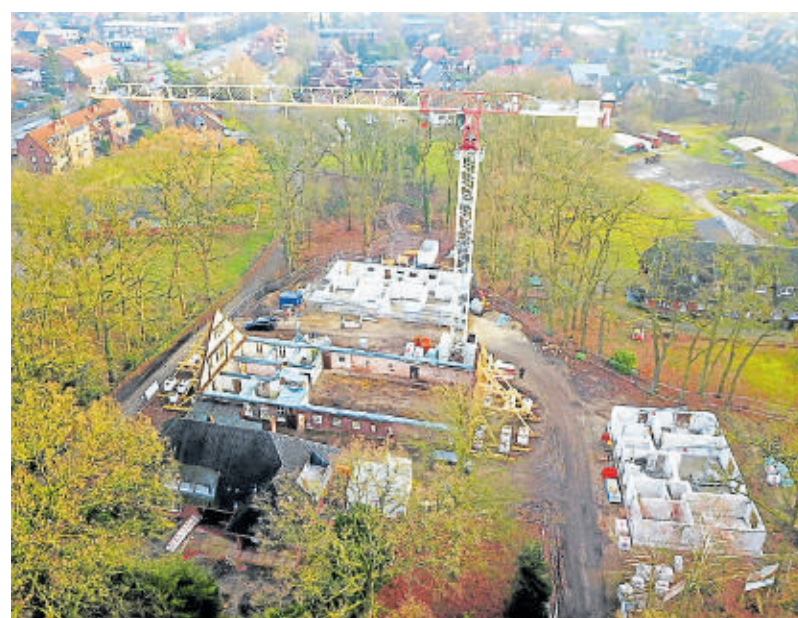
Vom Bauernhaus stehen fast nur noch die Mauern: Das Luftbild zeigt die Großbaustelle im Fischbeker Grün. Foto: Schulenburg
